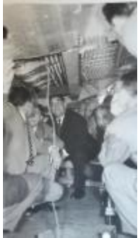
Visite d'inspection - 28 mai 1960 (7 NUM 12)
